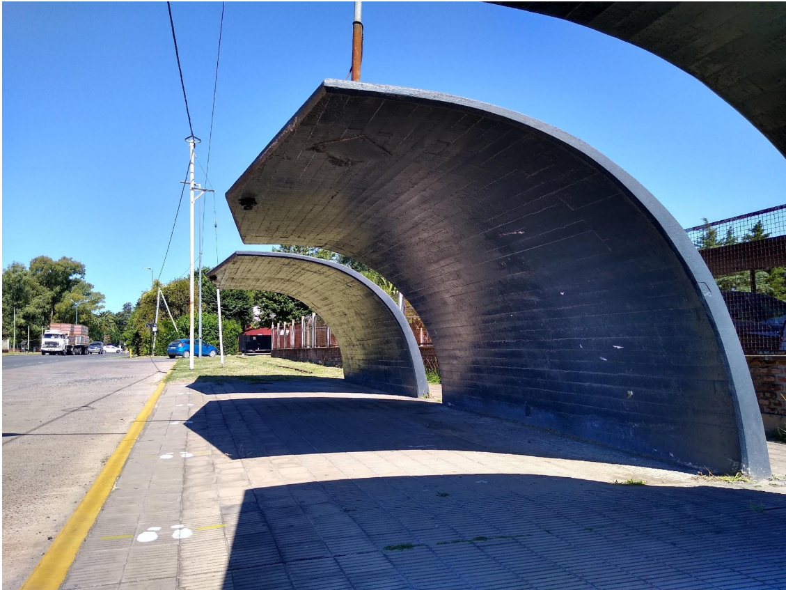
Figura 1: INVISIBLE A LOS OJOS. Parada de ómnibus frente a la República de los Niños. El espacio está definido por una lámina de sección cilíndrica. En las formas de la ciudad se encuentran geometrías que anidan en las matemáticas.
